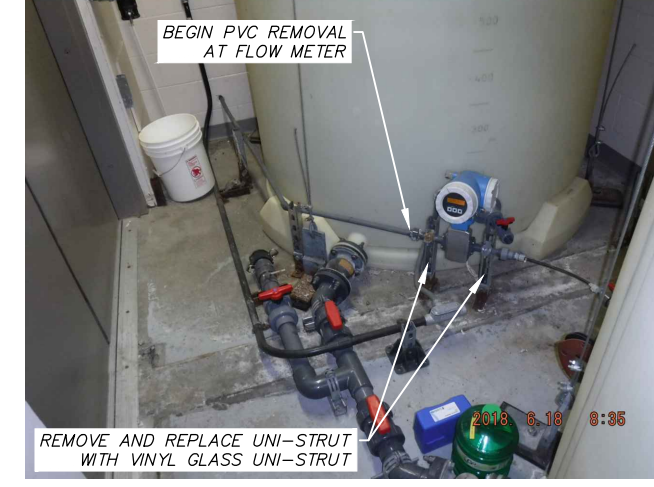
(D) CHLORINE ROOM FLOW METER NOT TO SCALE
